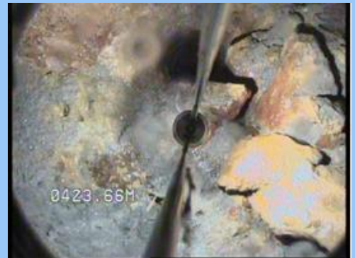
Derrumbe de sondeo sin entubar
